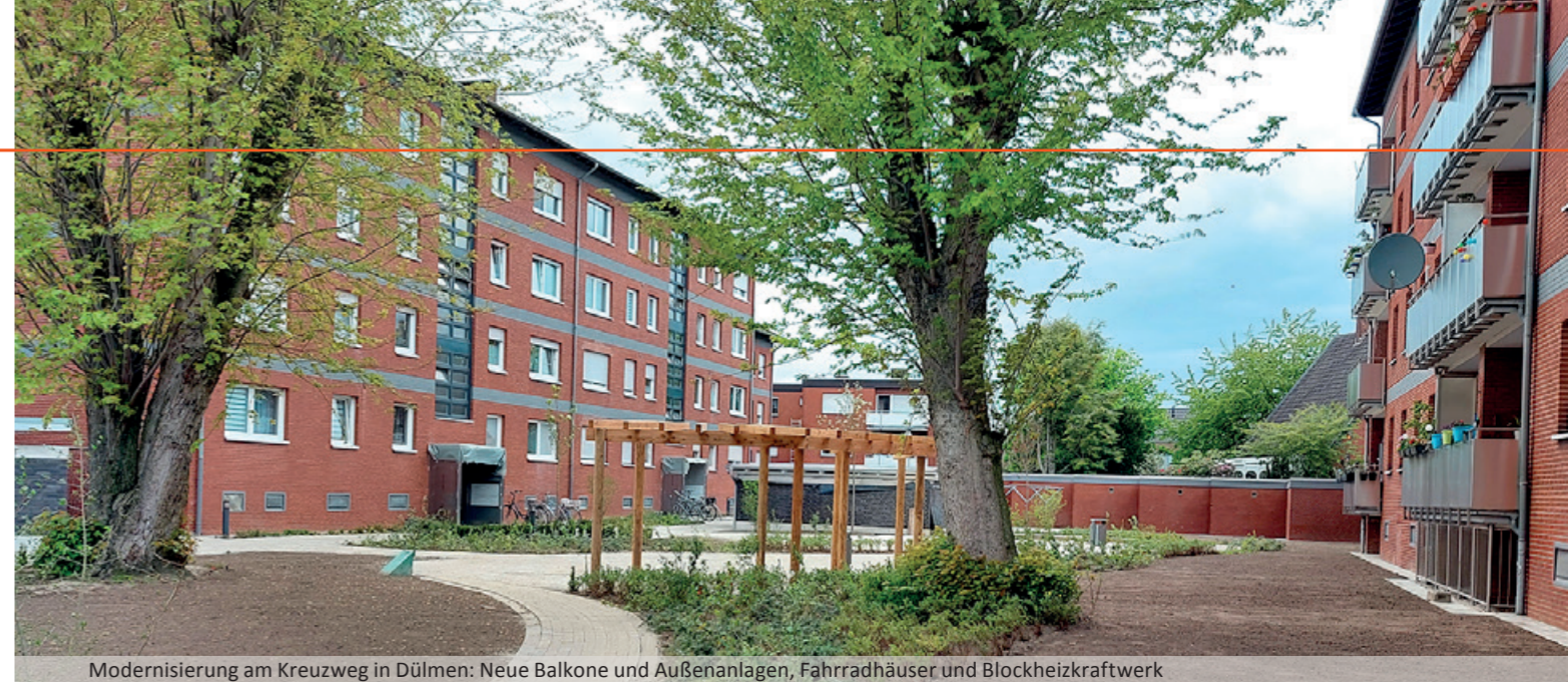
Modernisierung am Kreuzweg in Dülmen: Neue Balkone und Außenanlagen, Fahrradhäuser und Blockheizkraftwerk
