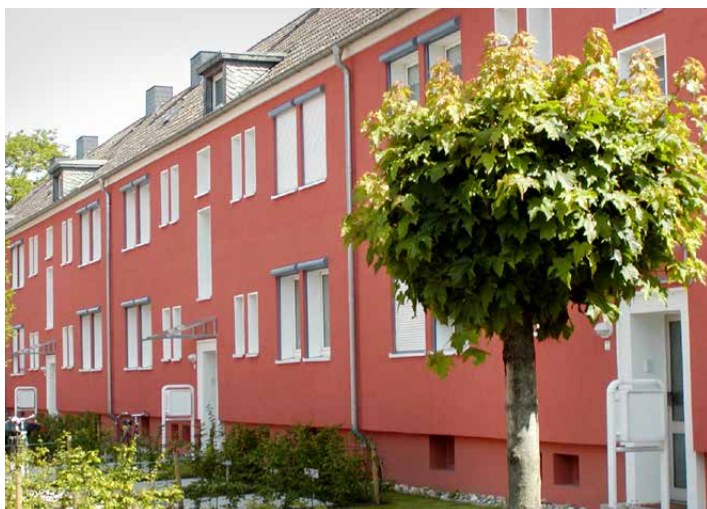
Häuser an der Steinbicker Straße in Coesfeld mit neuer Wärmedämmung
