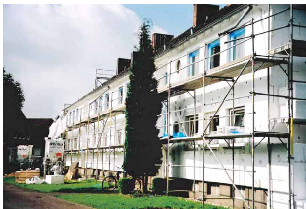
Hengtering/Ludgeri-Schul-Platz während und nach der Modernisierung
