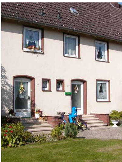
Häuser an der Breslauer Straße in Coesfeld ohne (l.) und mit neuer Wärmedämmung (r.)
