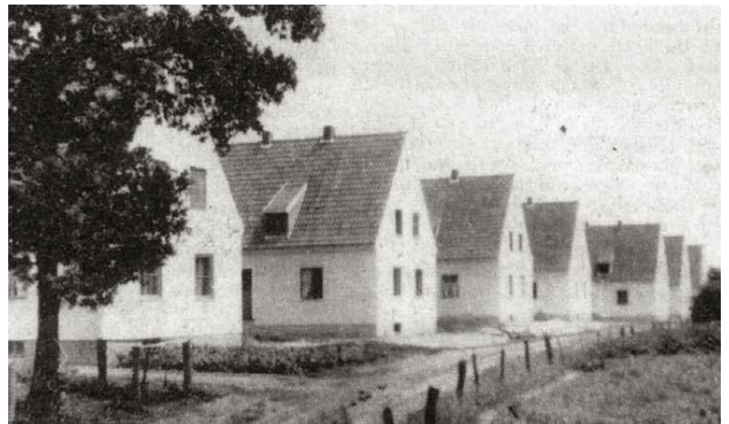
Siedlungshäuser im Dülmener Ortsteil Rorup im Jahr 1952 – entstanden mit viel Eigenleistung und mithilfe der WSG
