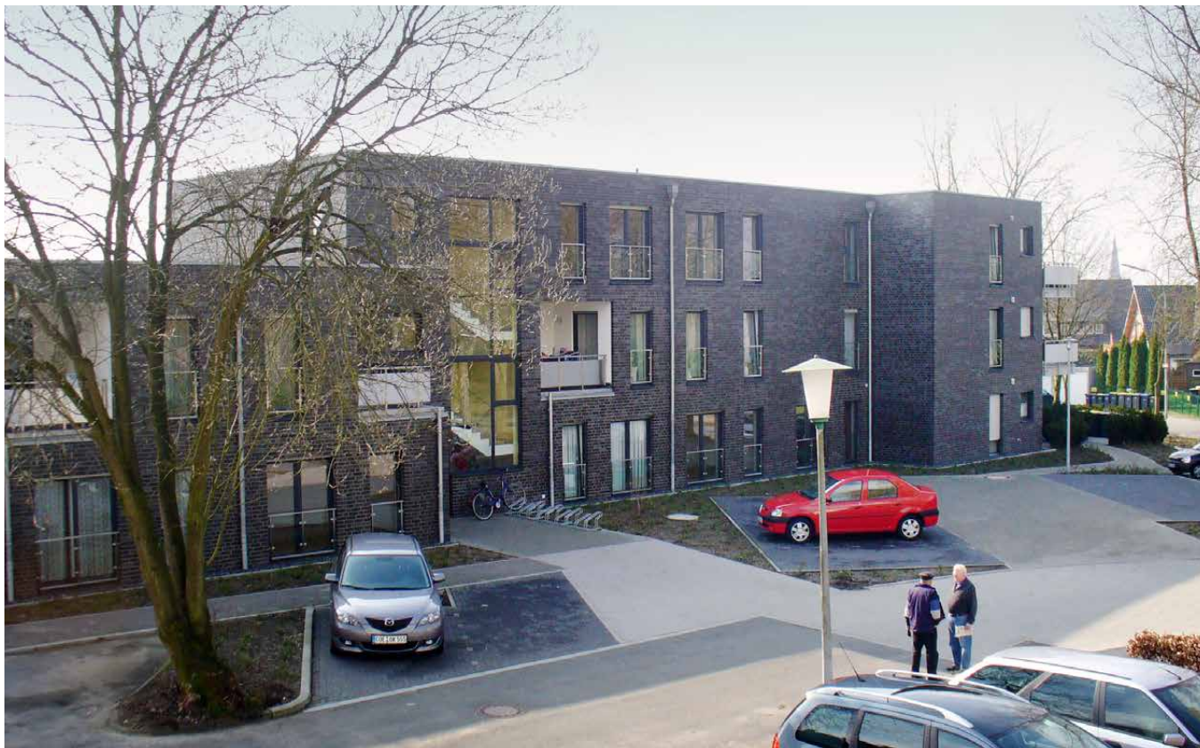
Neubau Billerbecker Straße in Dülmen (Bezug 2009)
