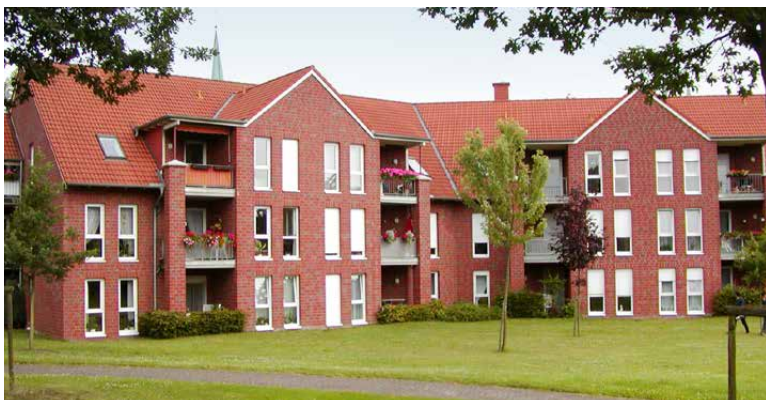
Altenwohnanlage „Baumgarten 16“ in Billerbeck (Bezug 1994)
