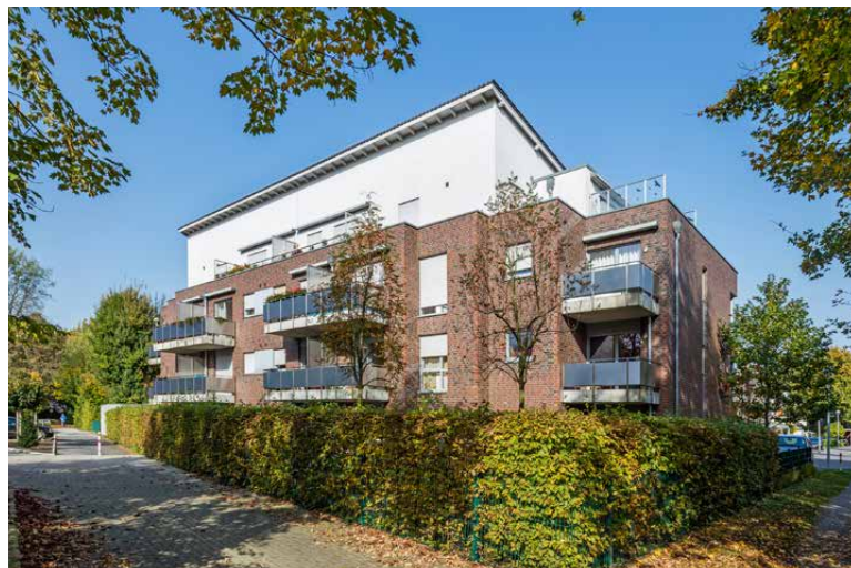
Seniorenwohnheim „Am Alten Freibad“
