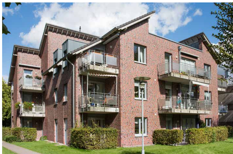
Seniengerechte Wohnungen in der Wohnanlage „Baumgarten 16a“ in Billerbeck (Bezug 2004)
